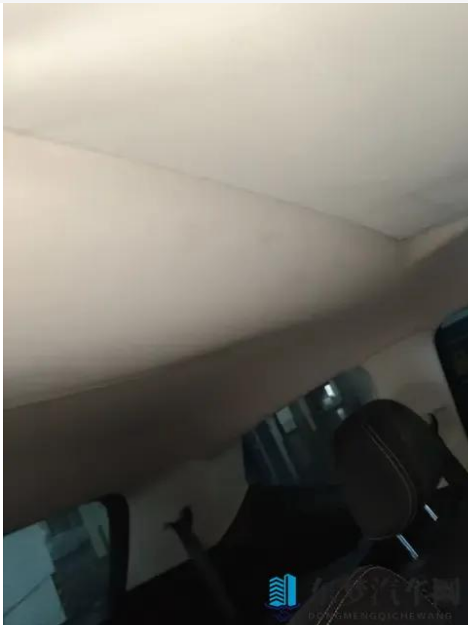
内饰检测中，顶棚有脱落的情况。
