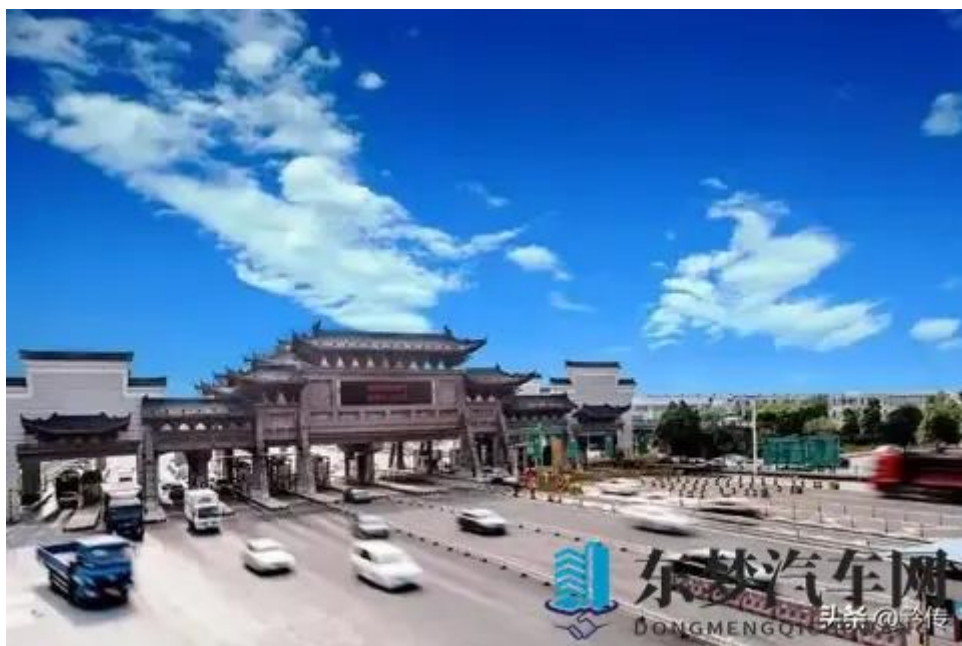
杭长高速长沙收费站。（图源湖南省交通运输厅）
